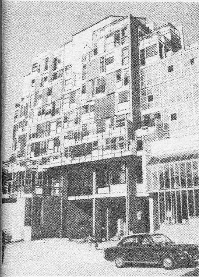
Рис. 154. Люсьен Кролл и Ателье. Здания медицинского факультета, Лувенский университет близ Брюсселя, 1969—1974 гг. Искусственный город-холм, включающий различные виды деятельности, артикулированные разными строительными системами. Обширная застекленная часть относится к общественной сфере, здесь расположен также ресторан; остальные материалы — дерево, кирпич, пластик, алюминий и бетон — также использованы семантически. Включены традиционные знаки: оранжереи, скатные крыши и каминные трубы, обозначающие более частные зоны. Разнообразие общего решения и детализировки выказывают ту постепенность в принятии решений, которая возникает с течением времени и придает всякому старому городу его неповторимый облик
