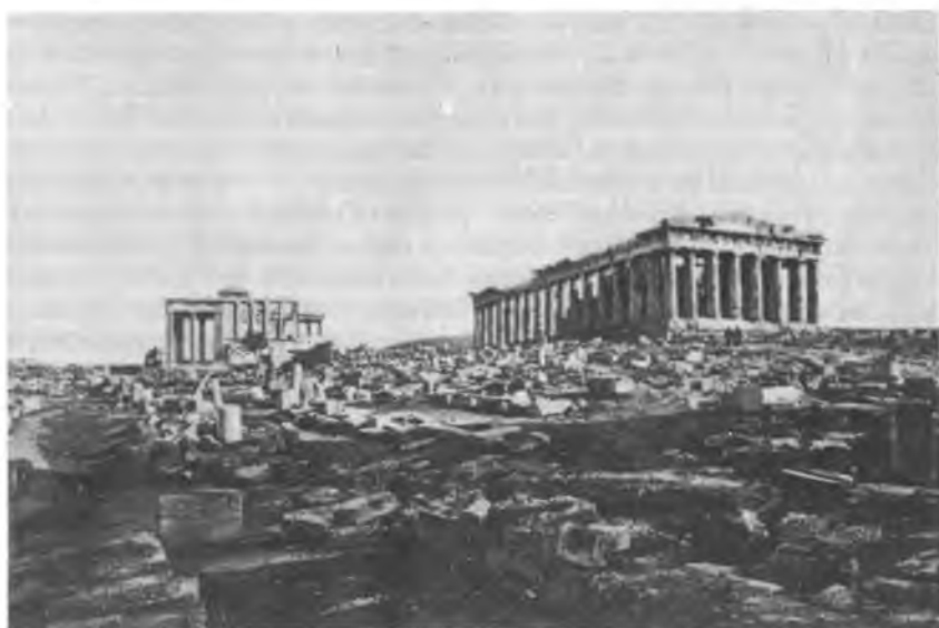
Рис. 7. Холм Афинского Акрополя и постройки архитектурного комплекса.
